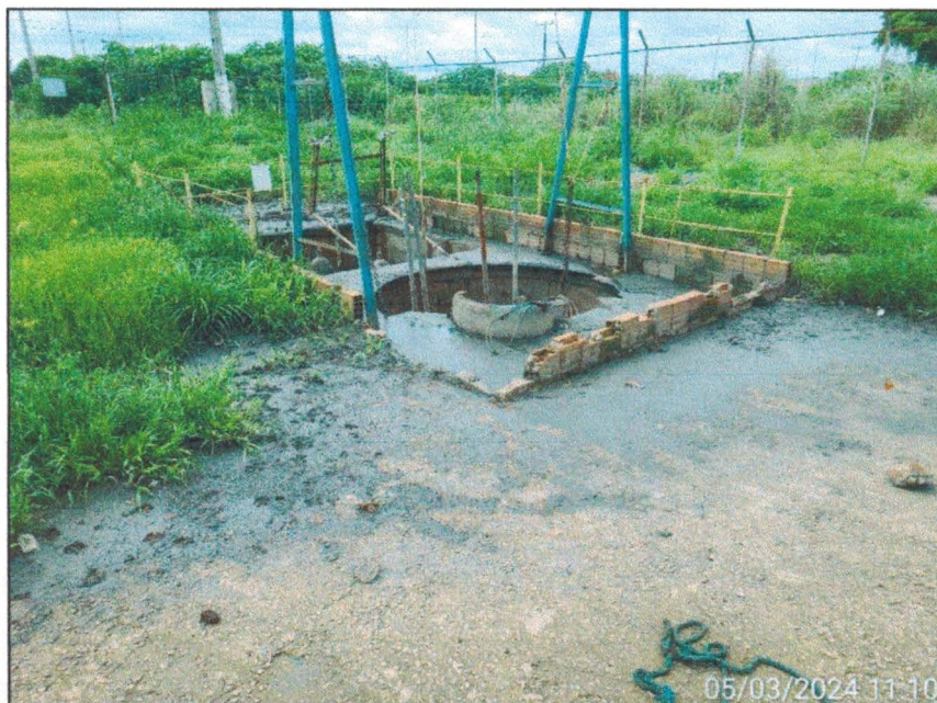
Imagem 13: Detalhes das marcas de derramamentos de esgoto e da mureta de contenção danificada na elevatória Greenville.
