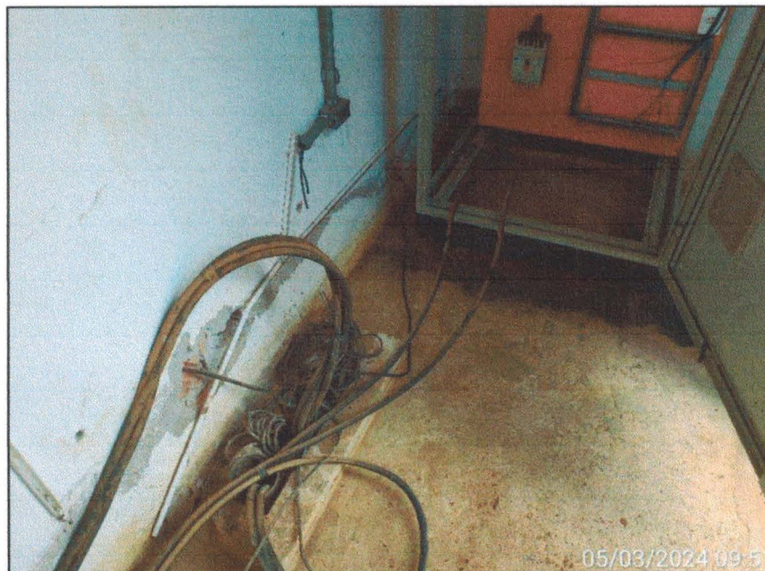
Imagem 02: Detalhe das fiações elétricas expostas na casa de comandos da EEE Albatroz.
