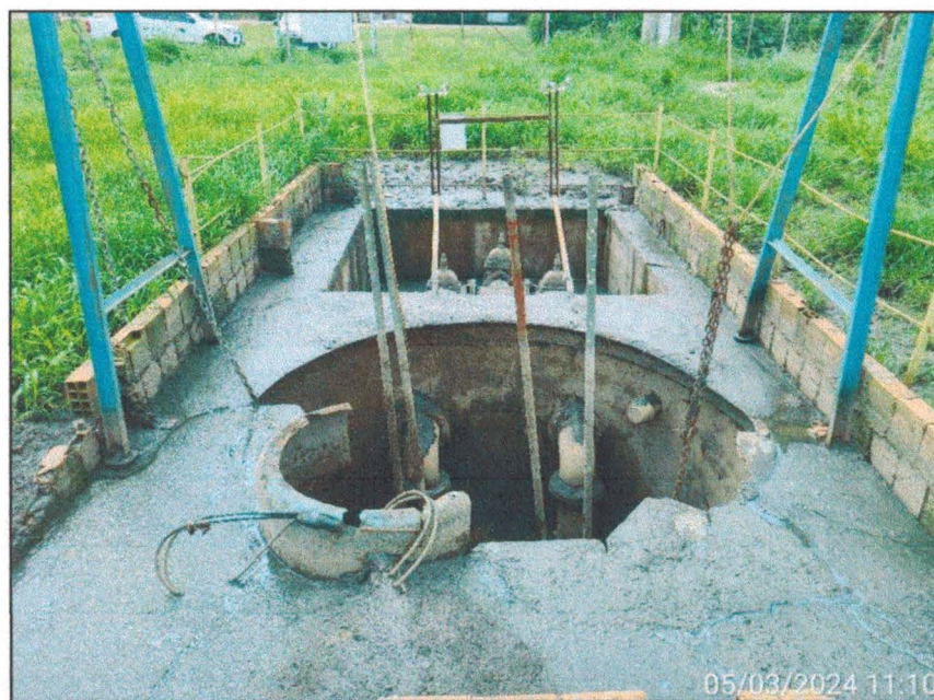
Imagem 14: Detalhes dos poços sem tampa de proteção e das grades danificadas na EEE Greenville.
