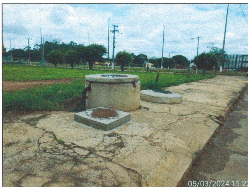
Imagem 18: Detalhe da elevatória Magel com ausência de identificação e de cercamento.
