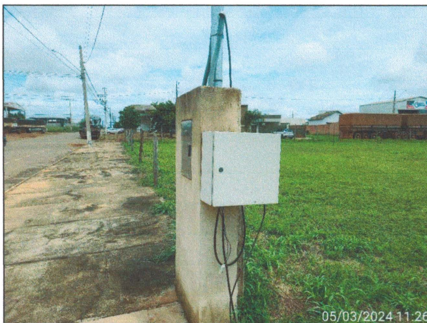
Imagem 19: Detalhes das fiações elétricas expostas do quadro de comando das ausências de extintor de incêndio e cercamento - EEE Magel.
