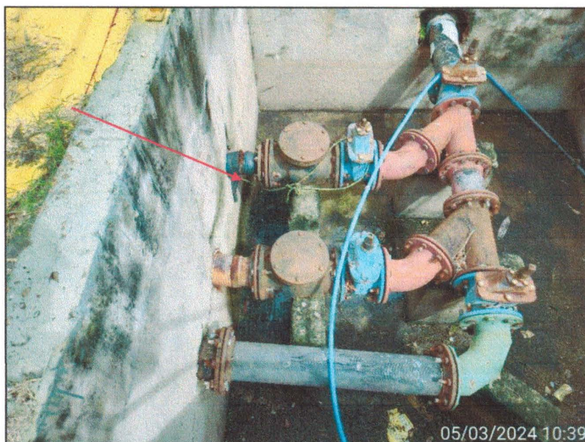
Imagem 05: Destaque para o vazamento na saída do poço de sucção da EEE Eckert.
