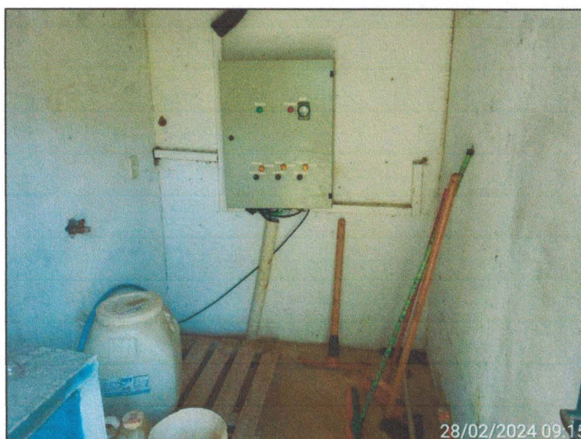
Imagem 10: Detalhe da sala do quadro de comando com produtos químicos, ferramentas e materiais de limpeza. Fonte: AgerBarra.
