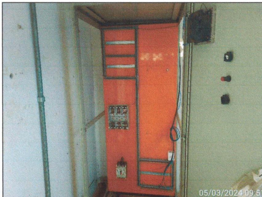
Imagem 01: Detalhe da ausência do inversor de frequência reserva na EEE Albatroz.
