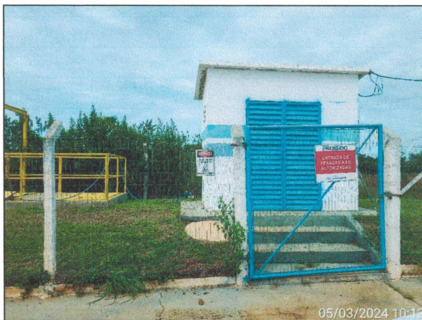
Imagem 03: Detalhes da EEE Santa Rosa e das ausências de refletores para a iluminação noturna e de extintor de incêndio.
