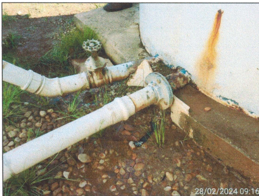
Imagem 13: Detalhe do vazamento na saída do tanque de filtração. Fonte: AgerBarra.
