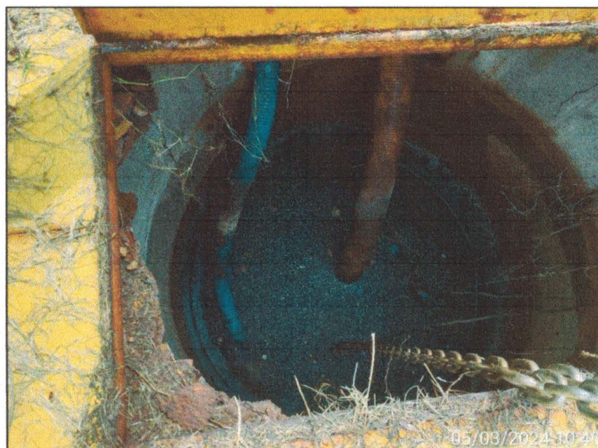
Imagem 06: Detalhe para o poço de sucção da elevatória Eckert com 01 conjunto motobomba instalado.
