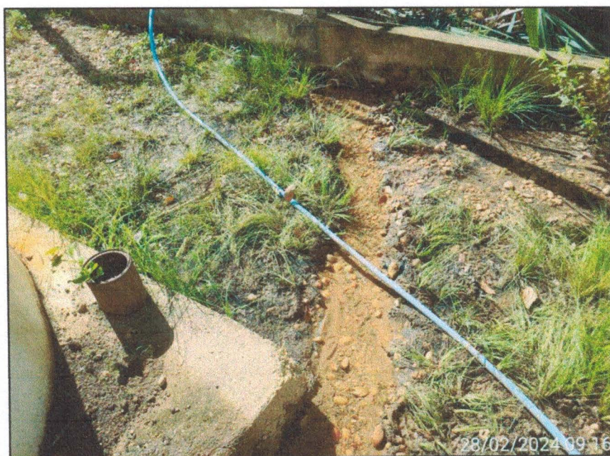
Imagem 14: Detalhe do local de passagem do vazamento da água filtrada. Fonte: AgerBarra.
