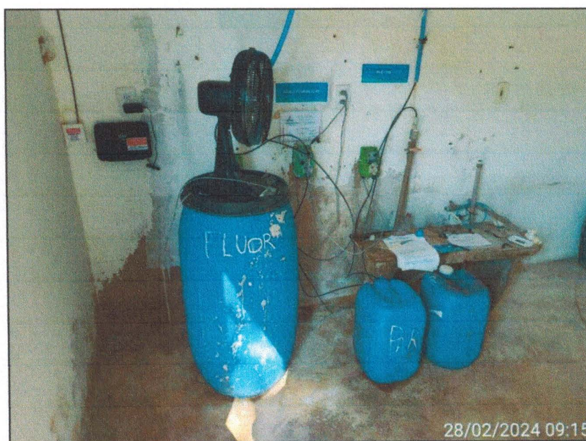
Imagem 08: Detalhe dos produtos químicos, dosadoras, ventilador e modem de internet. Fonte: AgerBarra.
