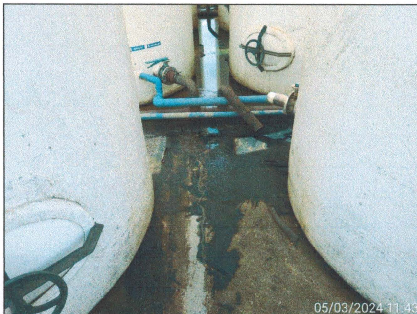
Imagem 25: Detalhe do derramamento de lodo na área dos tanques de tratamento – ETE Rio das Mortes.
