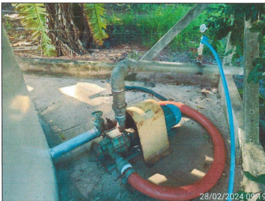
Imagem 03: Detalhe da EAT sem o conjunto motobomba reserva. Fonte: AgerBarra.
