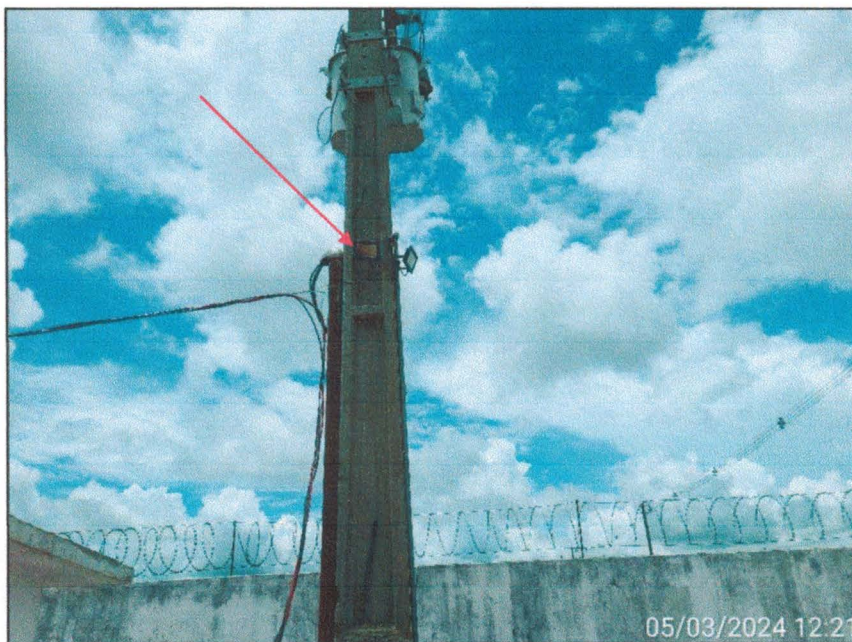
Imagens 21: Destaque para o refletor com a lâmpada queimada – EEE Apae.
