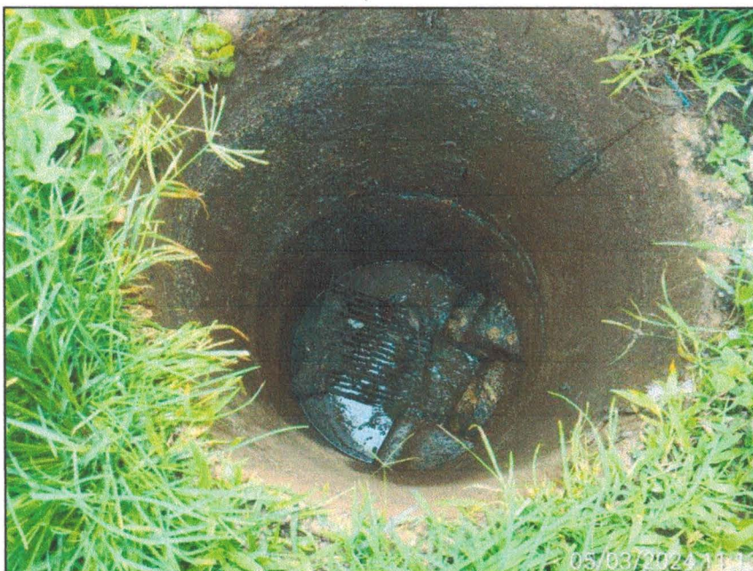
Imagem 17: Detalhe do poço do pré-tratamento com o gradeamento deficitário.
