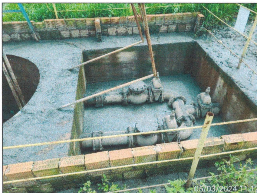
Imagem 16: Detalhe do poço das tubulações com esgoto acumulado – EEE Greenville.
