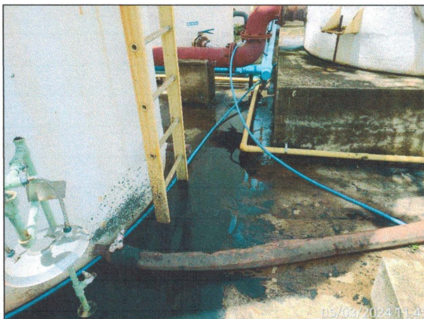
Imagem 24: Detalhe do derramamento de lodo na área dos tanques de tratamento – ETE Rio das Mortes.
