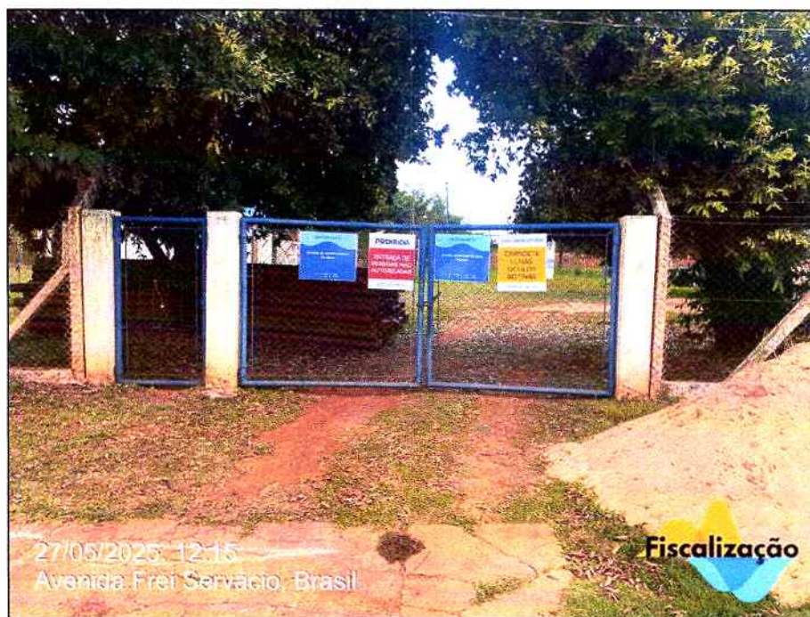
Imagem 01: Detalhe da entrada.
