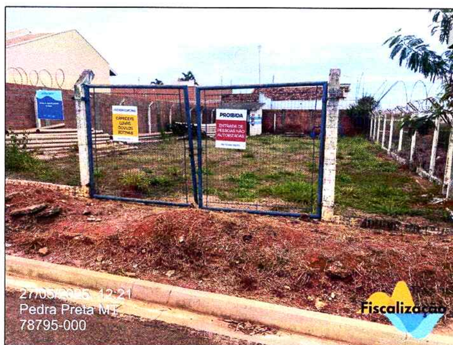
Imagem 01: Detalhe da entrada.
