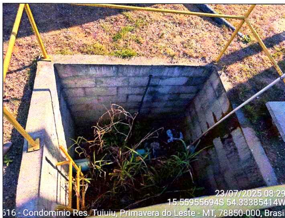
Imagem 02: Detalhe falta de limpeza e vazamento.
