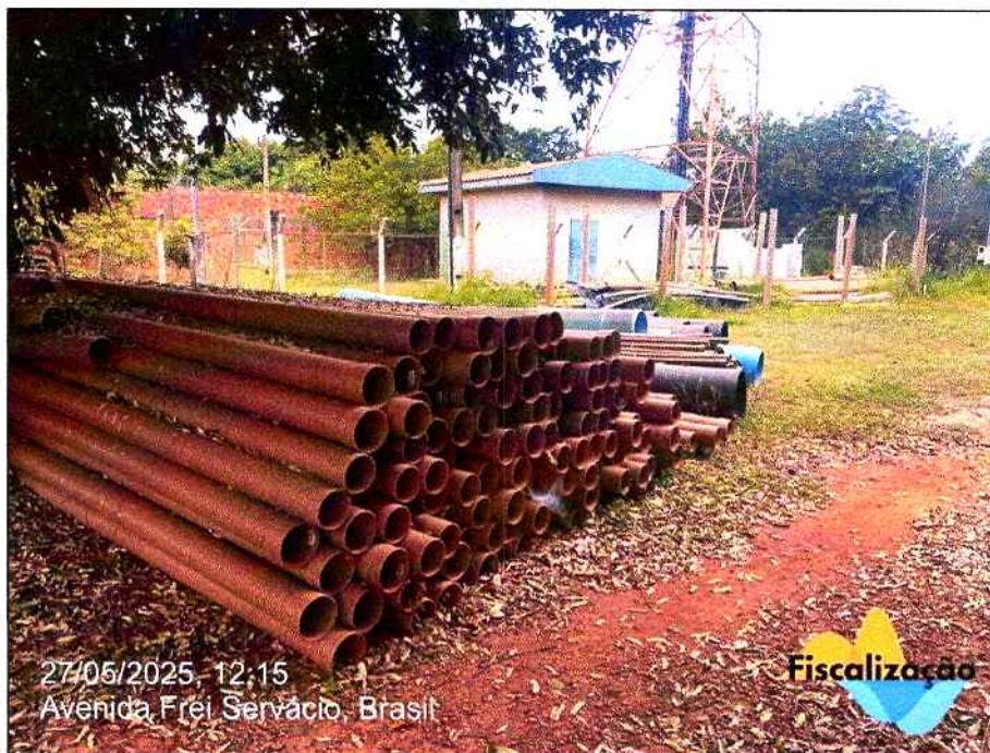
Imagem 02: Detalhe de tubos expostos.
