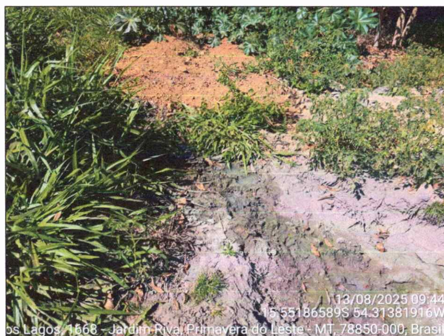
Imagem 03: Evidência de Extravasamento.
