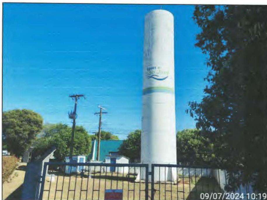
Imagem 43: Detalhe do RAP Prefeitura tipo torre.
