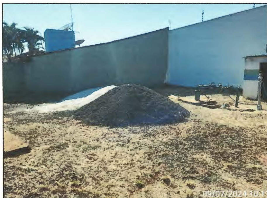
Imagem 38: Detalhe dos montes de brita e areia nas proximidades do poço P. Coelho.
