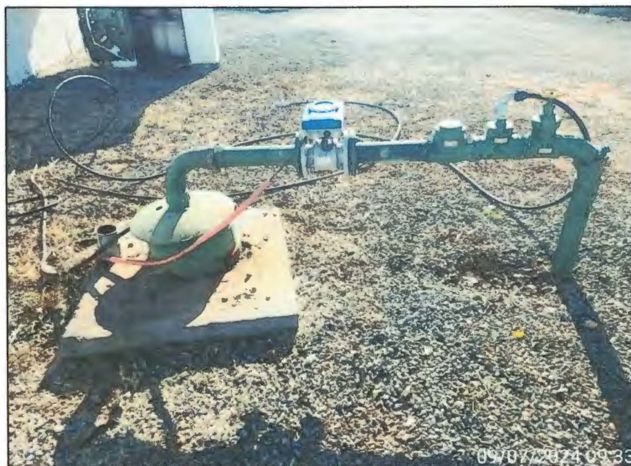
Imagem 20: Detalhe do PTP 09 na unidade Sede.
