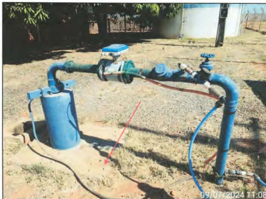
Imagem 69: Detalhe do PTP 10 e destaque para a laje de proteção semienterrada.
