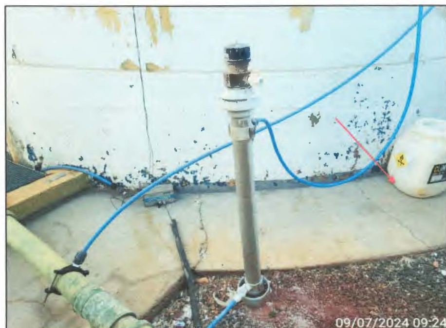
Imagem 14: Detalhe da dosadora de produto químico em pastilhas e destaque para bombona de produto químico armazenado no piso.
