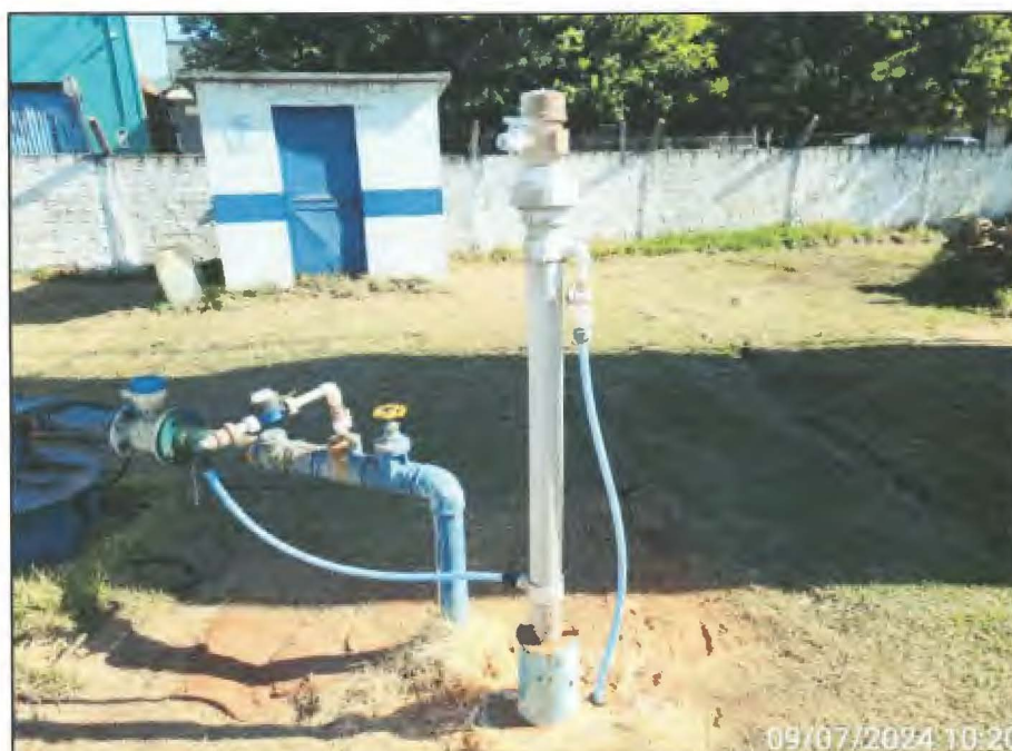
Imagem 46: Detalhe da dosadora de produtos químicos do PTP 08.
