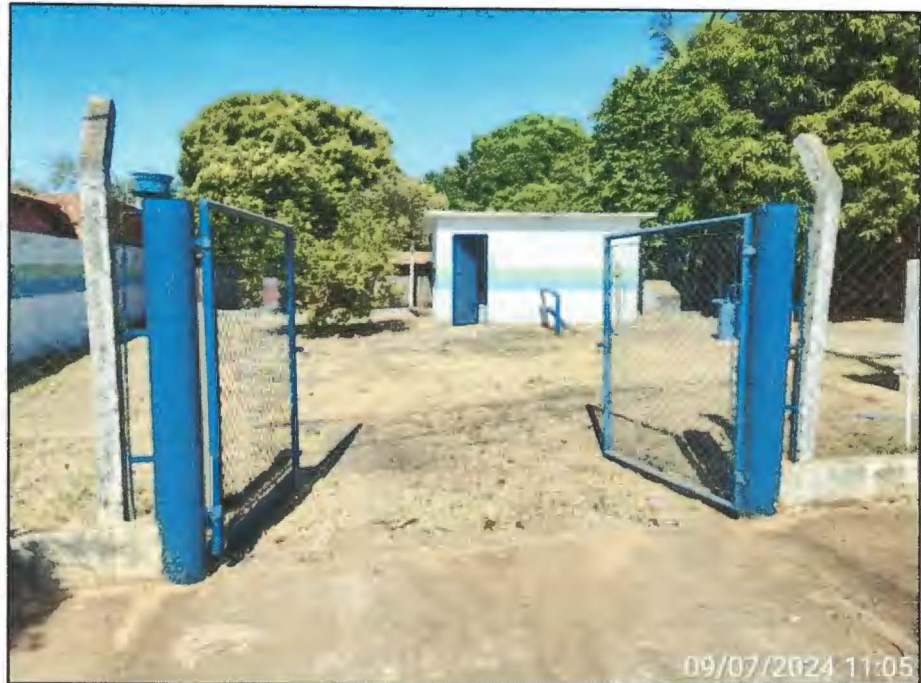
Imagem 67: Detalhe da unidade Jardim Olinda – PTP 10.
