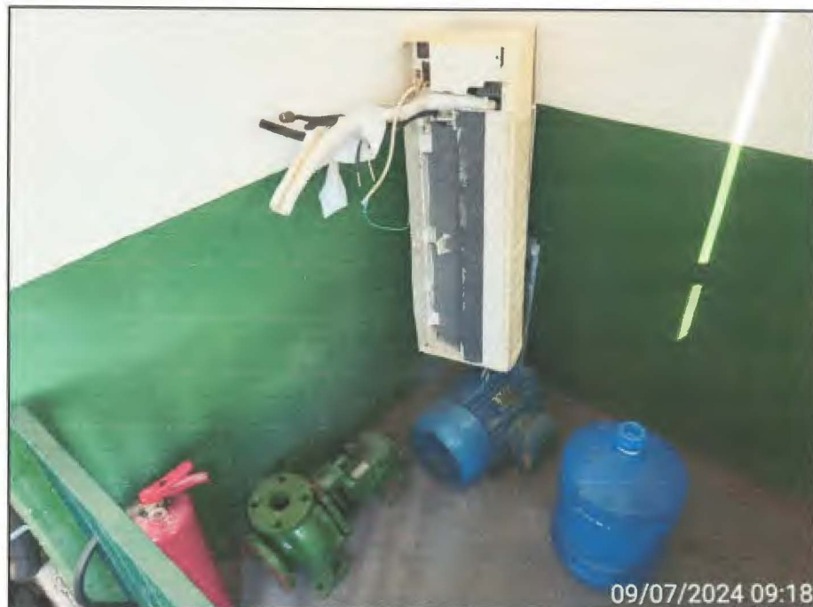
Imagem 13: Detalhe de equipamentos e materiais em desuso na EAT Sede.
