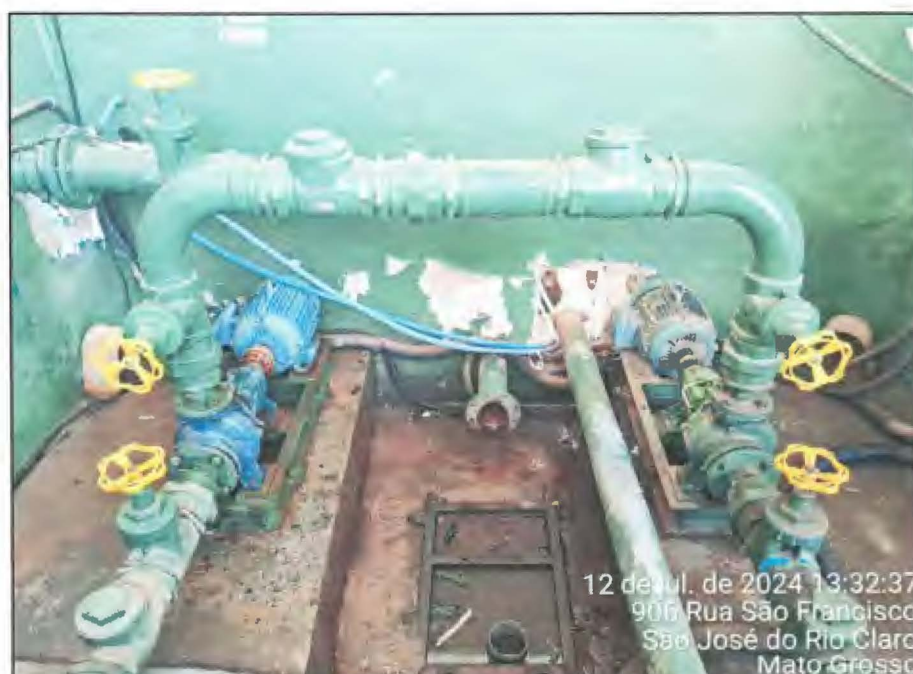
Imagem 82: Detalhe da EAT Sede com a correção do vazamento de água. Fonte: Águas de São José.
