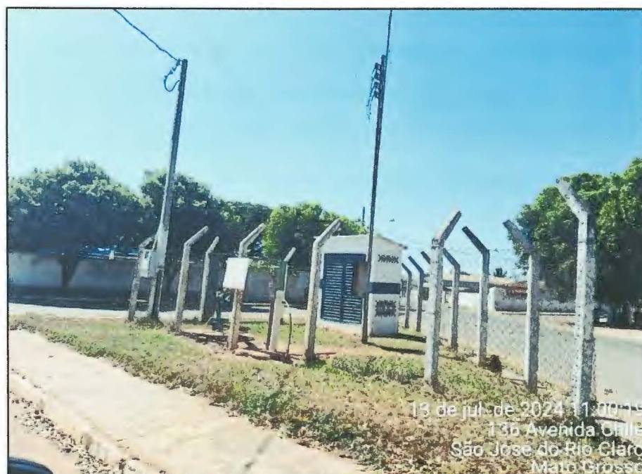
Imagem 84: Detalhe do pátio da unidade do Fórum sem a bombona de produtos químicos. Fonte: Águas de São José.
