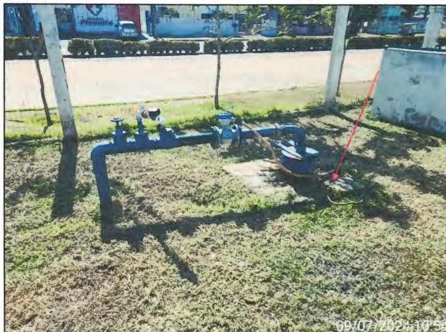
Imagem 61: Detalhe do PTP 12 e destaque para a laje de proteção semienterrada.
