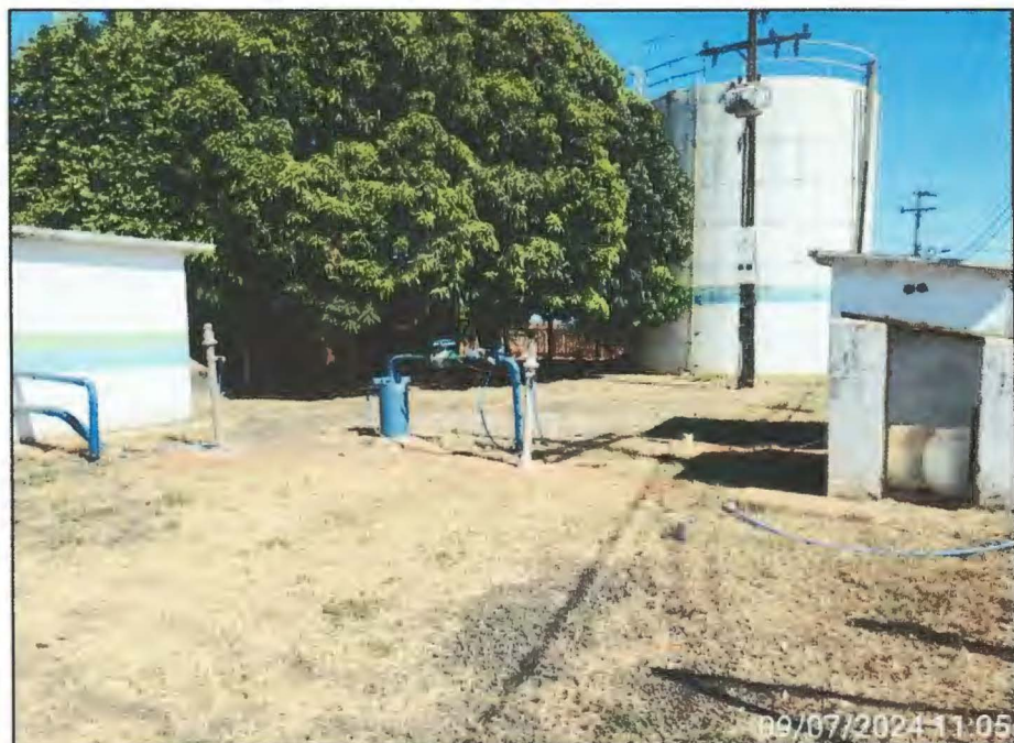
Imagem 68: Detalhe da unidade Jardim Olinda – PTP 10.
