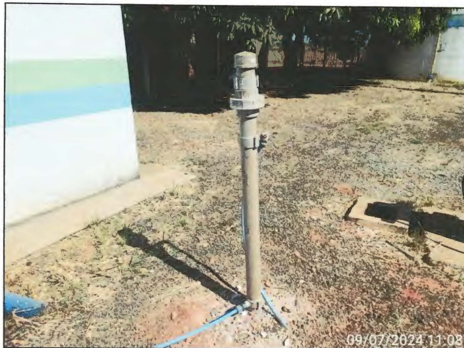
Imagem 77: Detalhes do dosador 02 da unidade Jardim Olinda.
