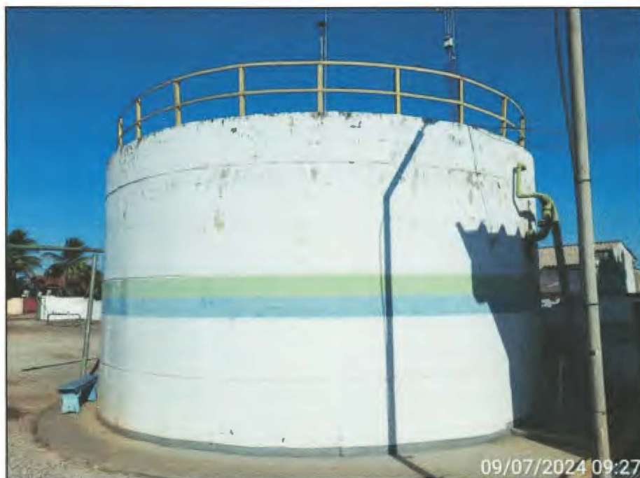
Imagem 15: Detalhe do RAP Sede.
