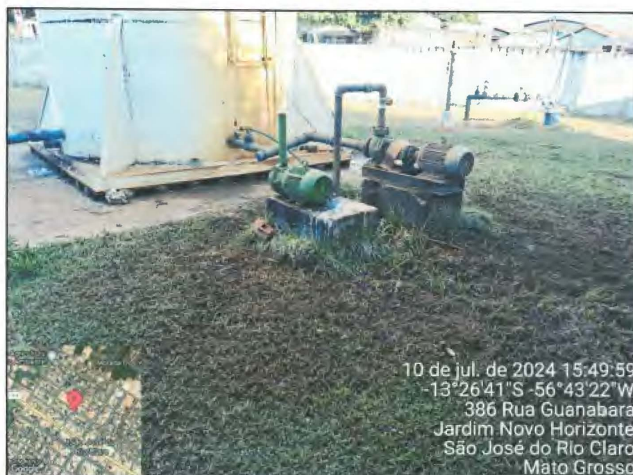
Imagem 81: Detalhe da EAT desativada da unidade Prefeitura com a correção do vazamento de água. Fonte: Águas de São José.
