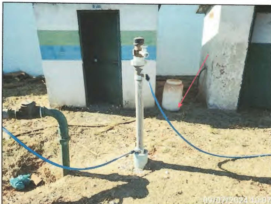
Imagem 37: Detalhe da dosadora e destaque para o produto químico no solo da unidade P. Coelho.
