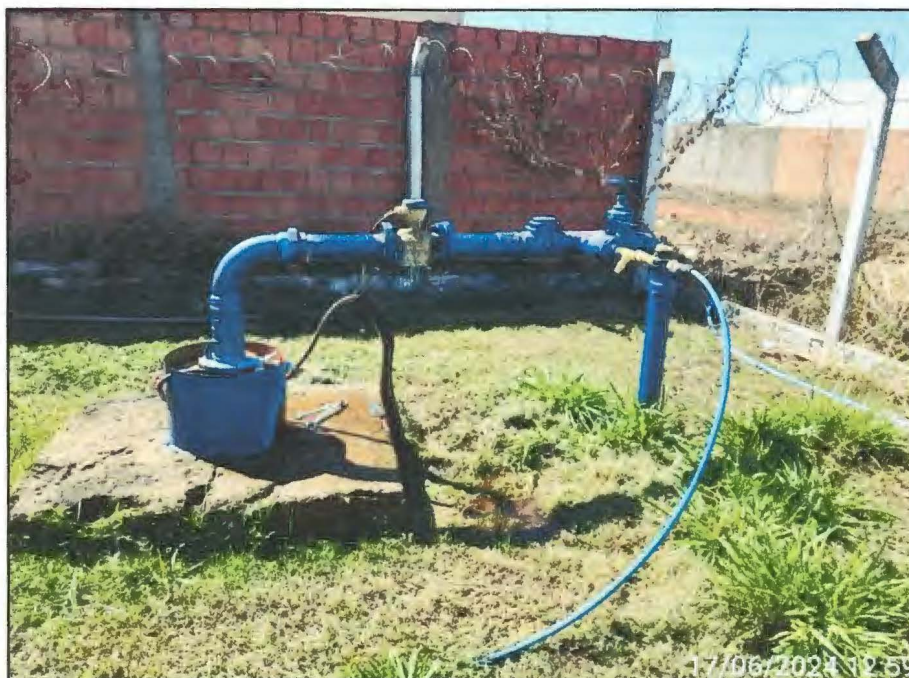
Imagem 02: Detalhe do poço em manutenção.
