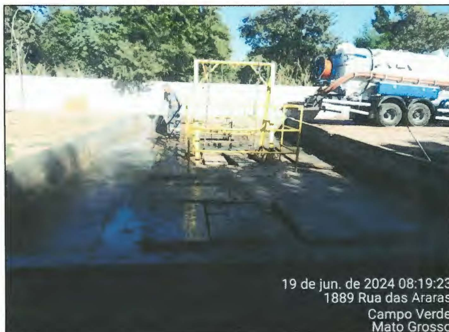
Imagem 06: Detalhe da limpeza do derramamento de esgoto na EEE Albatroz. Fonte: Águas de Campo Verde
