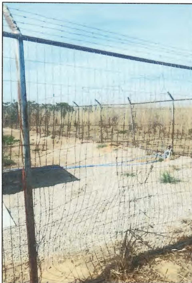
Imagem 07: Detalhe do reparo da tela do alambrado na EEE Greenville. Fonte: Águas de Campo Verde
