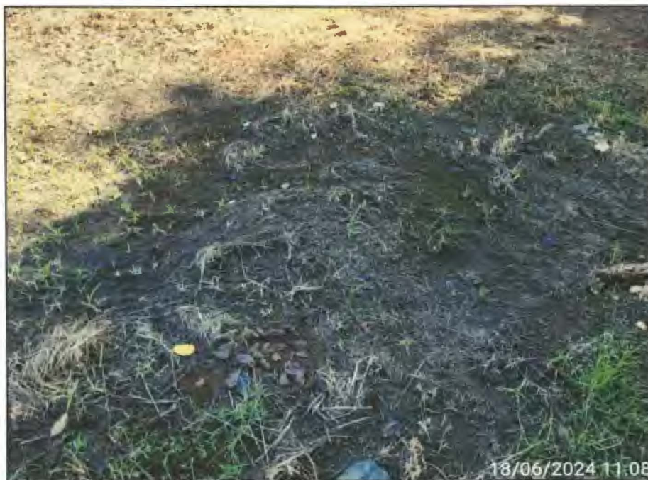
Imagem 04: Detalhe do derramamento de esgoto no pátio da elevatória Albatroz.
