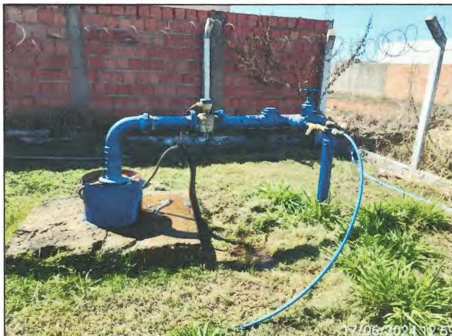
Imagem 02: Detalhe do poço em manutenção.
