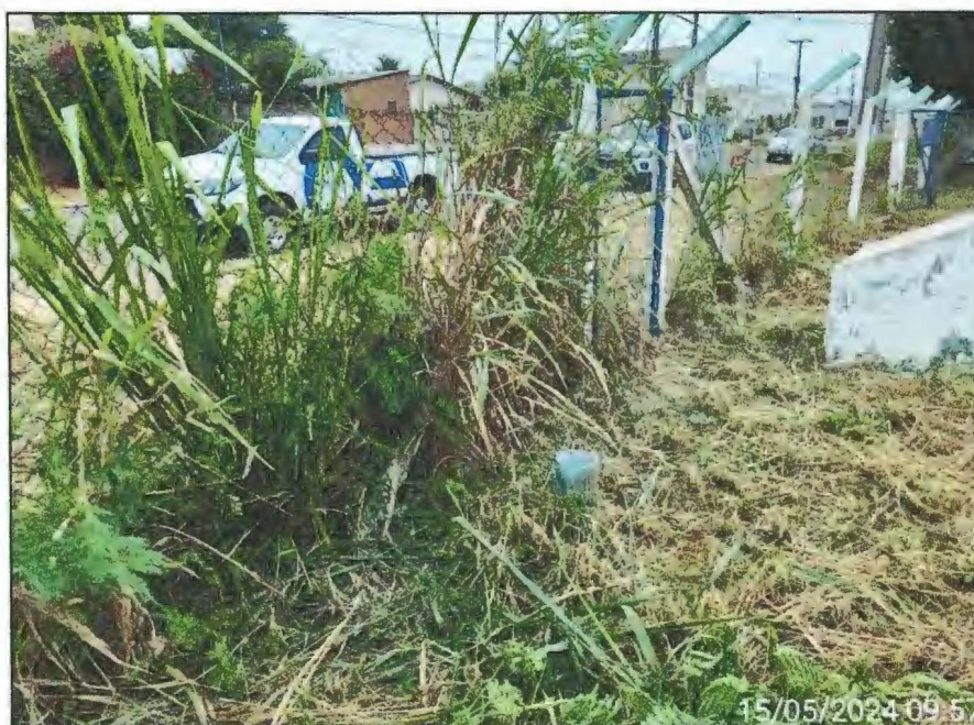
Imagem 12: Detalhe do excesso de vegetação na unidade PTP 02.
