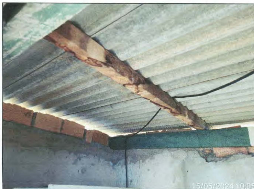
Imagem 17: Detalhe da ausência de iluminação noturna na sala de comando do PTP 14.
