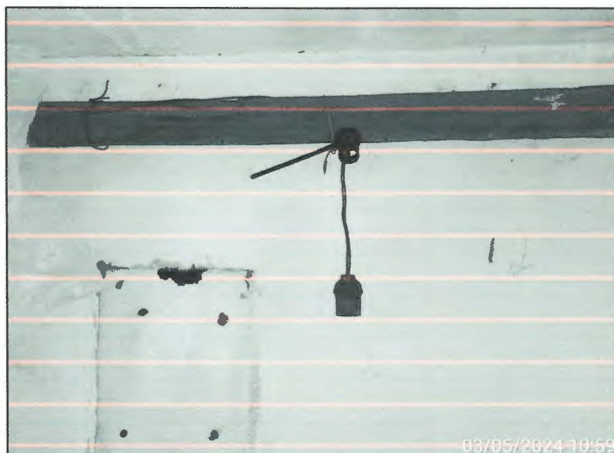
Imagem 11: Detalhe da sala do quadro de comando com ausência de iluminação noturna. Fonte: AgerBarra.
