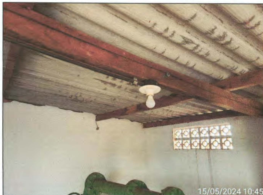
Imagem 23: Detalhe da ausência de lâmpada na casa de máquinas da unidade Santa Rosa.
