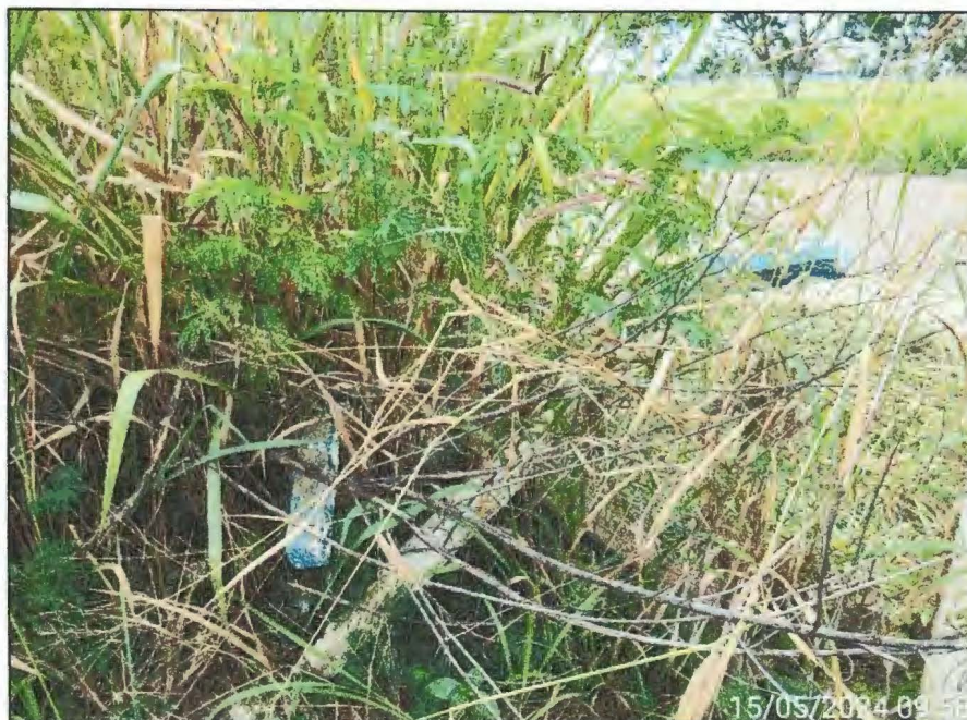
Imagem 11: Detalhe do alambrado danificado da unidade PTP 02.
