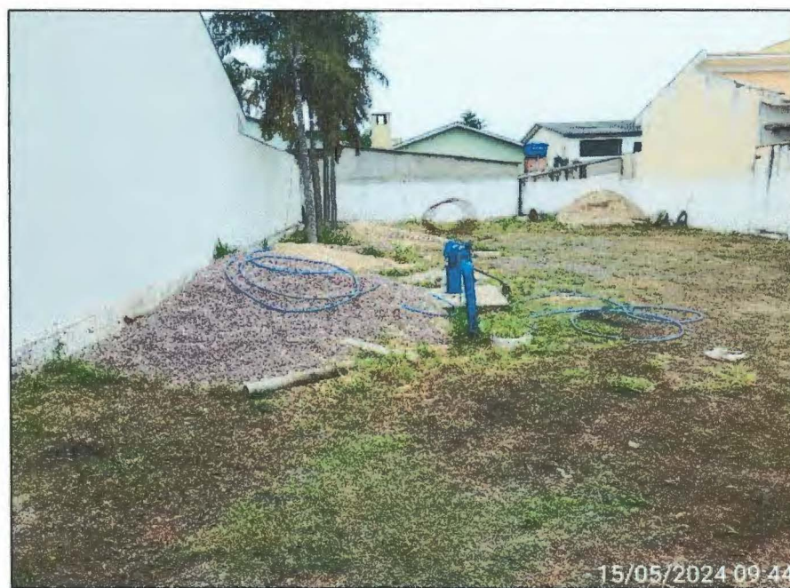
Imagem 08: Detalhe do armazenamento de cascalho em cima da laje de proteção do poço - Unidade PTP 05.
