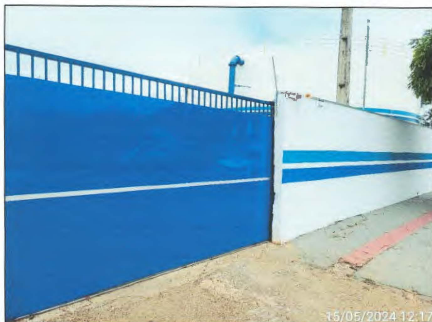
Imagem 01: Detalhe da ausência de placa de identificação com dados do Poço/EAT/RAP Sede.
