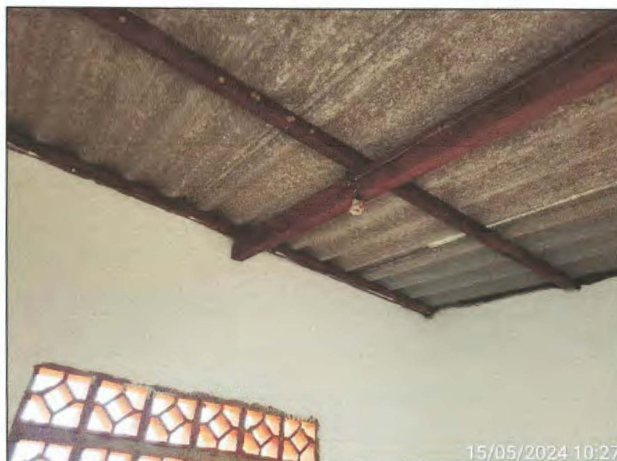
Imagens 21: Detalhe da ausência de lâmpada na sala de química da unidade Campo Real.
