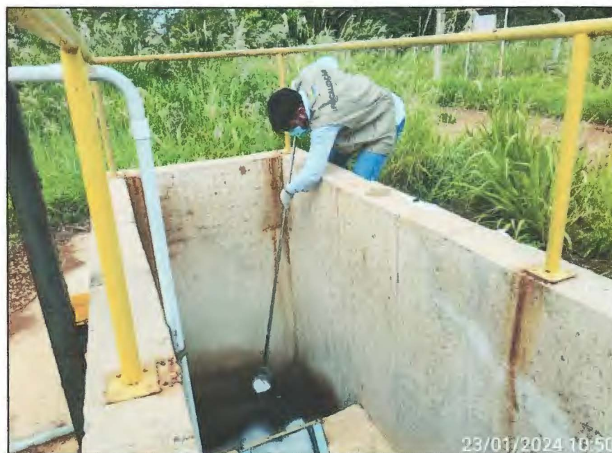
Imagem 03: Detalhe da coleta do esgoto tratado na saída da ETE Rio das Mortes – 23/01/2024.
