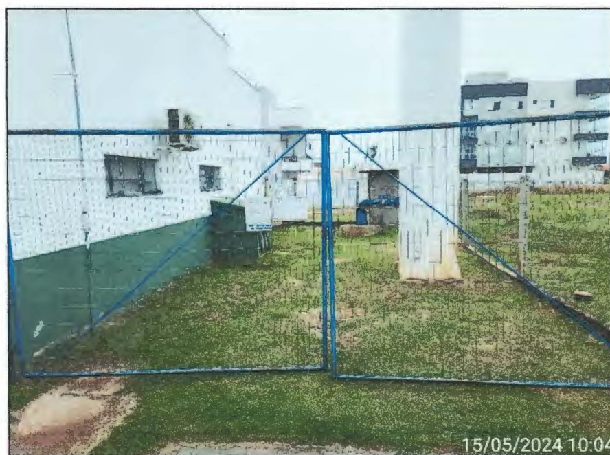
Imagem 14: Detalhe da ausência de placa de identificação da unidade PTP 14.
