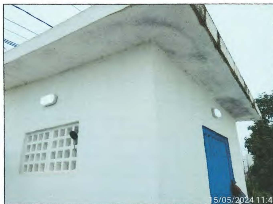
Imagem 38: Detalhe da ausência de extintor de incêndio na unidade PTP J. Ville.
